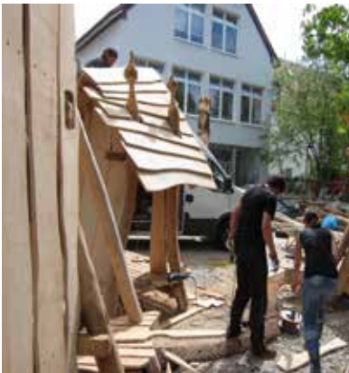
Abbildung 4: Aktive Umbauarbeiten (Foto: Barbara Stark)
