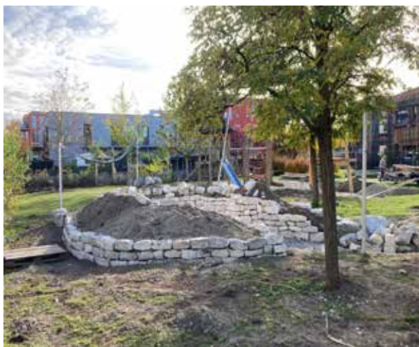
Abbildung 4: Natursteingarten während der Umbaumaßnahmen (Foto: Robert Schmidt-Ruii)
