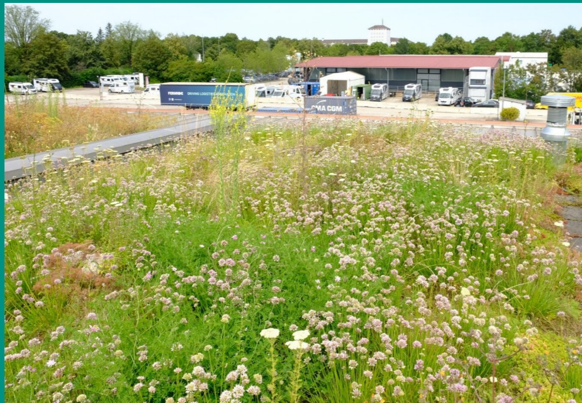
Dachbegrünung auf Gewerbebau
